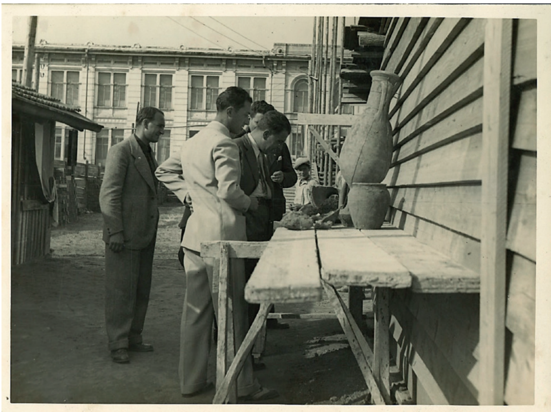
Il cantiere del OND, Opera Nazionale Dopolavoro di Vercelli, in una delle foto dell'Archivio fotografico Bona, durante una visita del Segretario Federale Piero Pozzo. Un'altra opera di grande rilievo e interesse della città nella cui storia si evince l'attenzione e la cura del costruito
