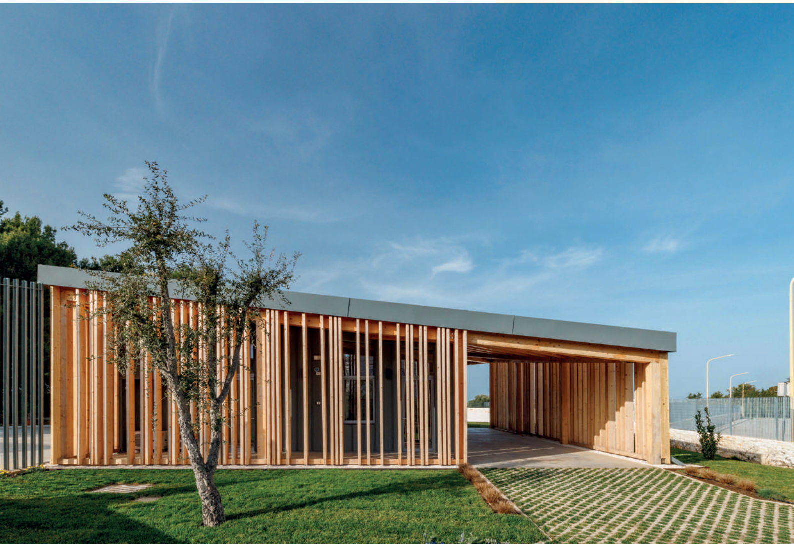
A.I.D.I Accoglienza in dispensa (BA), Mixtura Studio, Arch. Cesare Querci. Menzione speciale nell'ambito del Wood Architecture Prize by Klimahouse. Foto credits Cesare Querci
