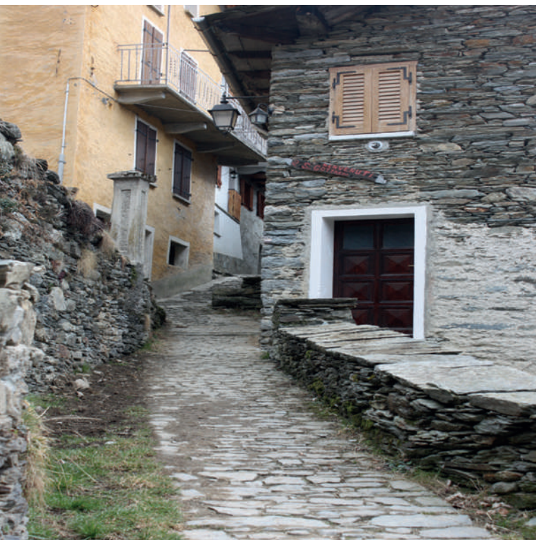
Strada di accesso alla frazione San Gottardo di Rimella
