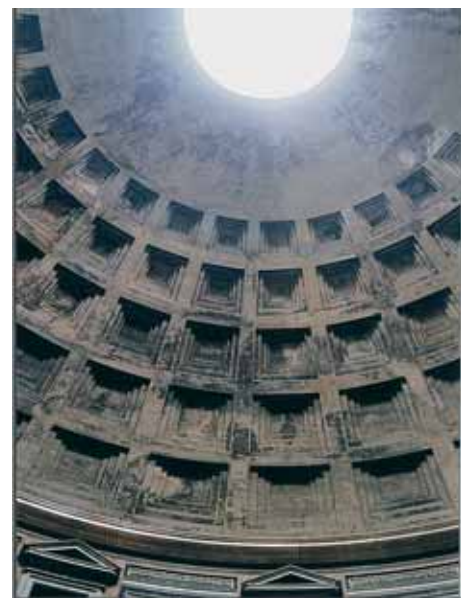
Intradosso della cupola prima dell'intervento di manutenzione.
