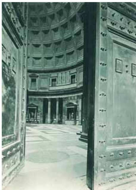
Apertura dell'anta prima dell'intervento.
