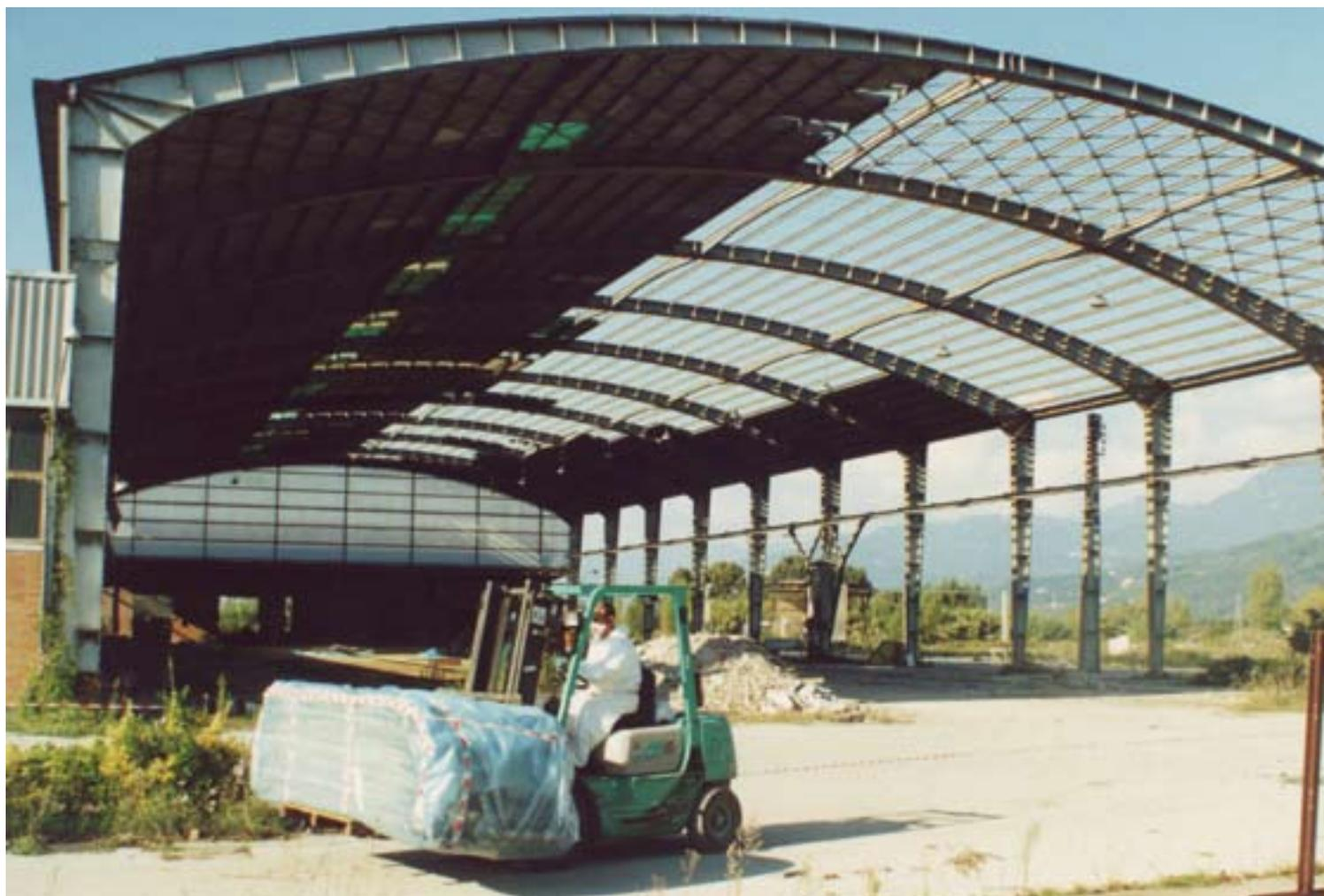
Rimozione di copertura in amianto-cemento
