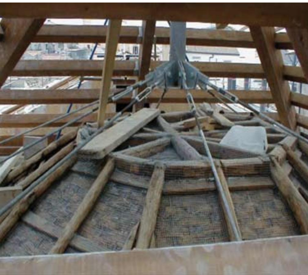
*Restauro della Chiesa di S. Eulalia dei Catalani in Palermo, particolare della ricostruzione del tetto della zona centrale della chiesa con capriate e travi in legno lamellare, tavolato e tegole*
