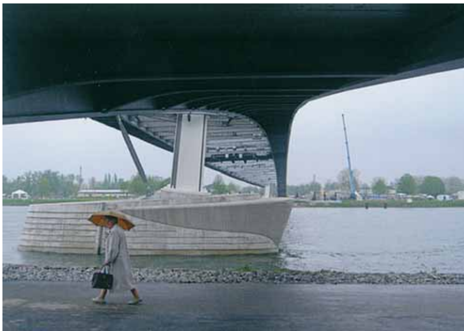
• Ponte pedonale sul Reno, veduta del pilone, Strasburgo-Kebe, Francia-Germania 2000-04.
