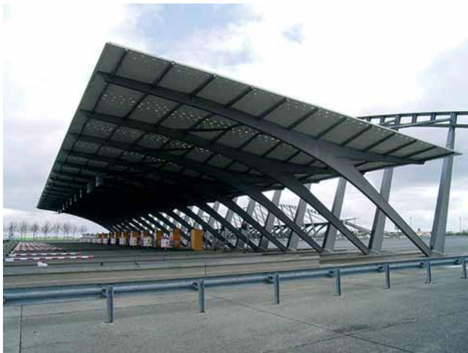
• Casello autostradale di Les Eprunes sulla A5, veduta, Melun, Francia 1991-94.
