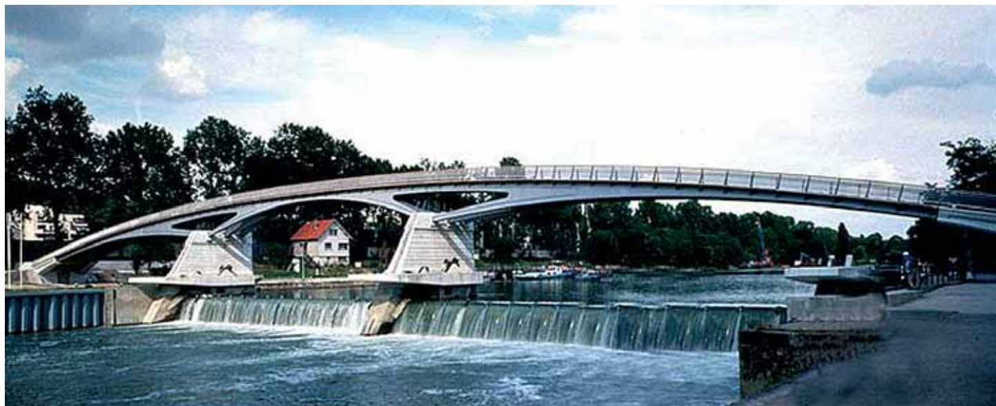
Ponte pedonale sulla diga di Saint-Maurice sulla Marna, Francia 1991-97.
