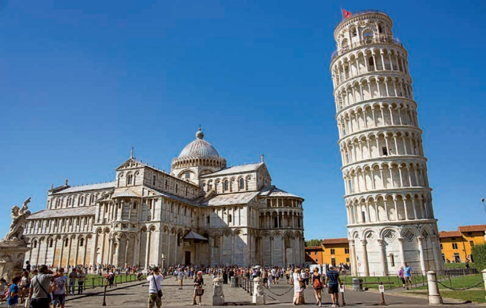
Si decise di ridurre l'inclinazione di un valore anche modesto che non modificasse l'aspetto della Torre, ma sufficiente a migliorare le condizioni di stabilità della fondazione e a ridurre le sollecitazioni nella struttura. L'intervento è stato sufficiente a riportarla in condizioni di sicurezza.
