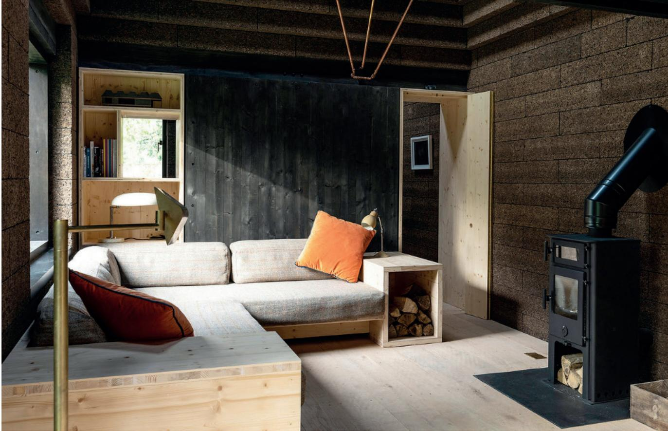
zato per realizzare strutture portanti. L'intera sezione della casa è fatta quindi di sughero naturale che vanta numerose proprietà: leggerezza, flessibilità, elasticità, resistenza al fuoco, traspirabilità, impermeabilità e riciclabilità.
