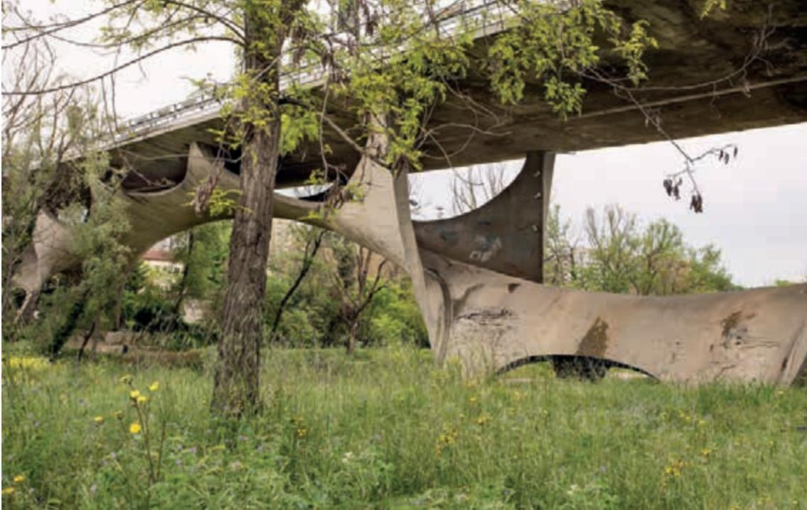
ca dell'arco limite, il Ponte sul Lao in Calabria, basato su un traliccio formato da elementi tutti in compressione e il Ponte Tor di Quinto a Roma, le cui membrane a "V" preludono al successivo progetto realizzato, il Ponte sul Basento a Potenza. Non meno straordinario, il progetto per il Ponte sullo Stretto di Messina, molto apprezzato da Bruno Zevi e che valse, a Musmeci, il primo premio ex-aequo per il sistema strutturale progettato.
