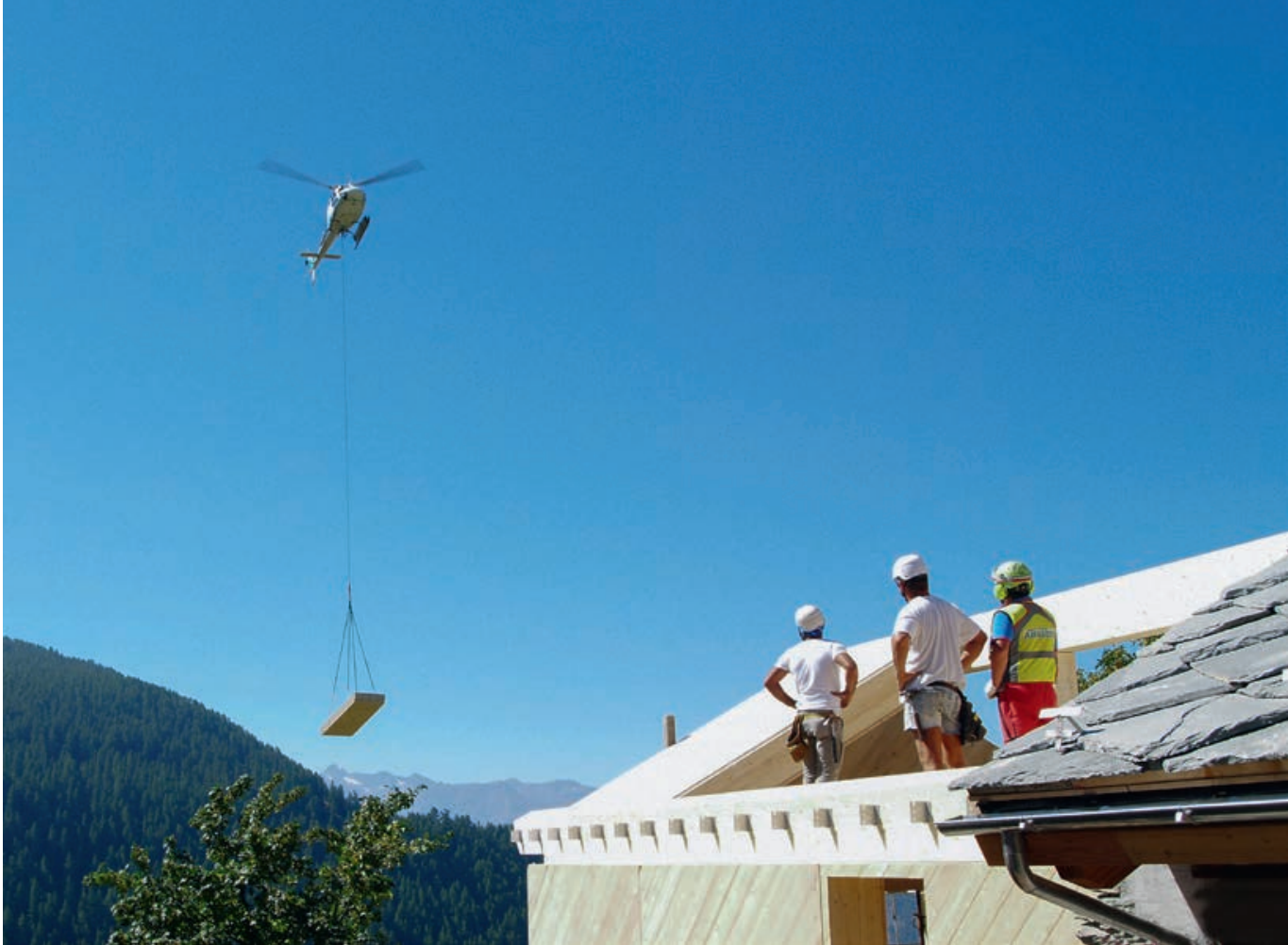
La casa UD in fase di realizzazione con l'ausilio di un elicottero. Foto arch. Tiziana Monterisi
