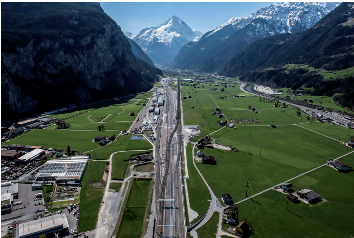
Stazione Flüelen, la "porta" nord della Galleria di base del Gottardo. Foto Swiss Travel System
