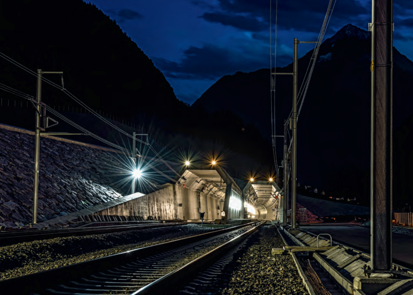
Uno degli ingressi della Galleria base del Gottardo. Foto Swiss Travel System
