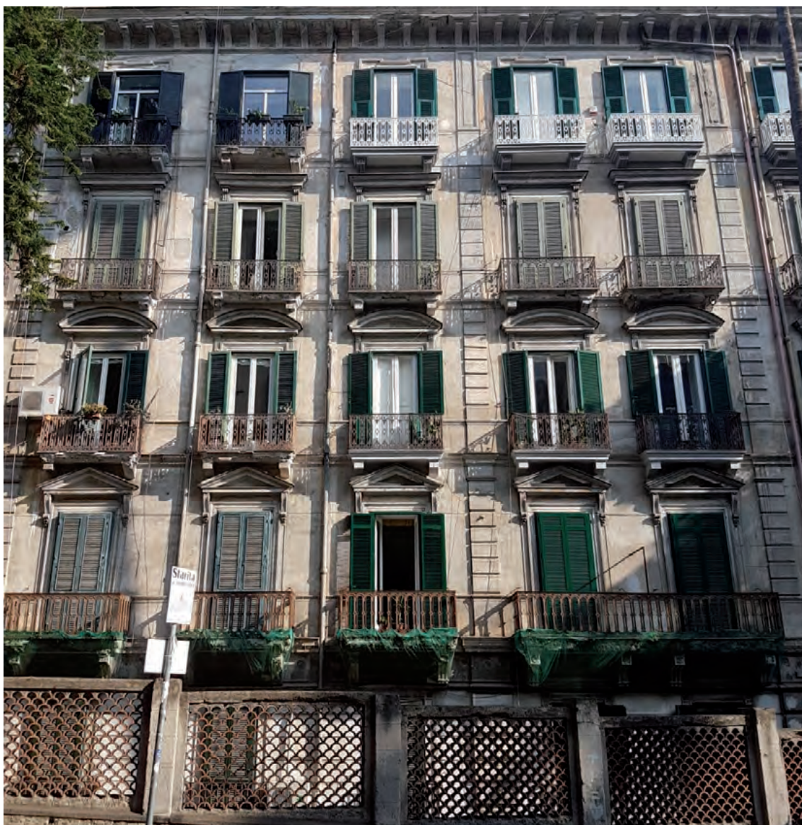
Napoli, fronte lungo via del Parco Margherita
