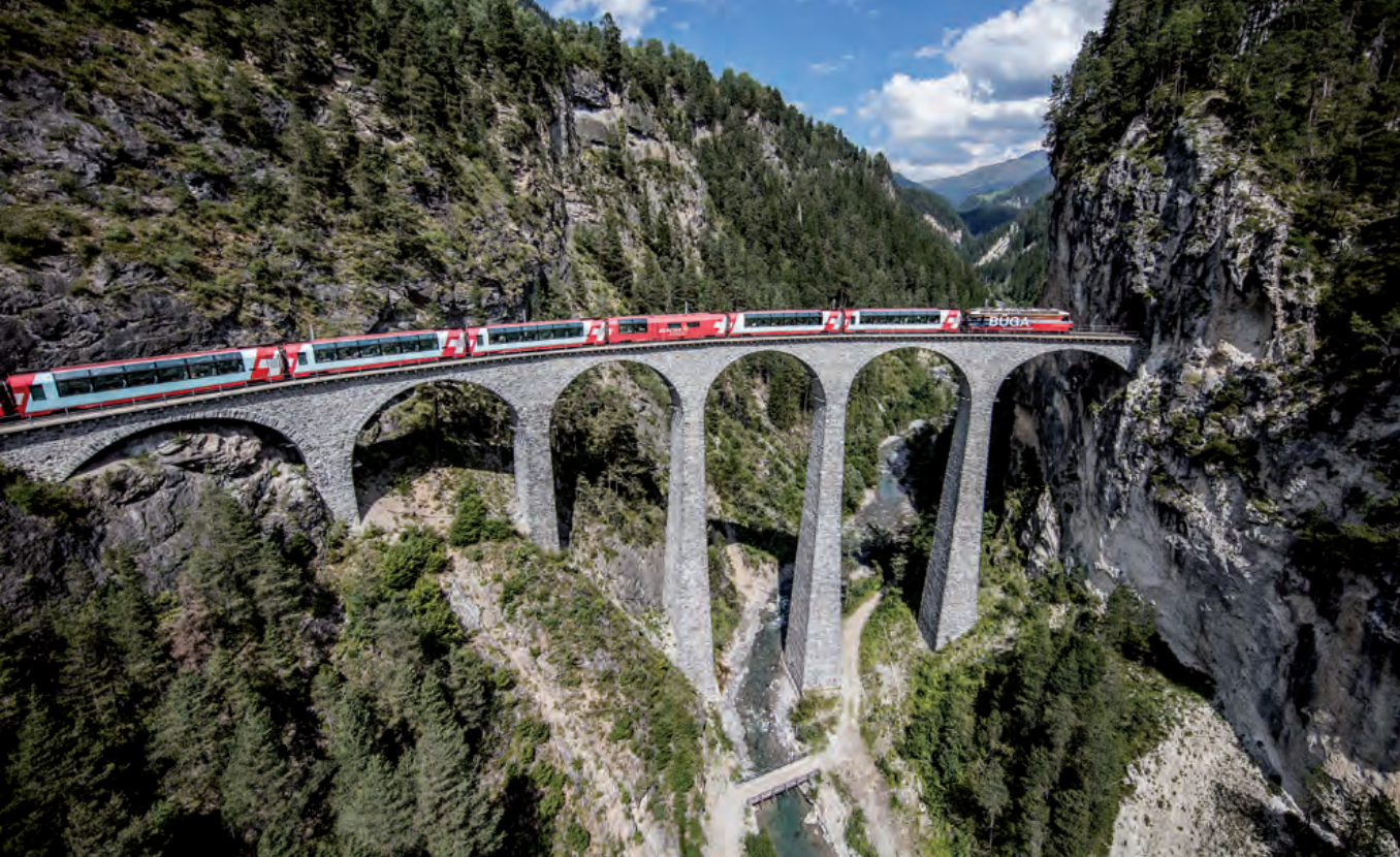
Il trenino rosso del Bernina in viaggio sul viadotto Wiesner. Foto Ferrovia retica
