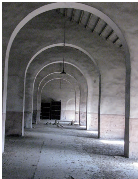
Piacenza, ex Caserma Vittorio Alfieri, già convento delle Benedettine, interno del fabbricato dell'inizio del XX secolo
