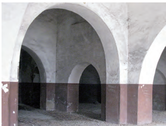
Piacenza, ex Caserma Vittorio Alfieri, già convento delle Benedettine, particolare del deposito
