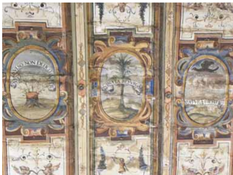
Dettaglio di uno dei soffitti a cassettoni
