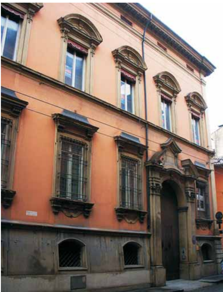
La facciata di Palazzo Rusconi, progetto di A. Torreggiani
