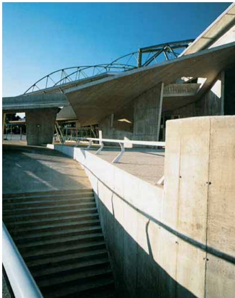
Palazzo dello sport a Huesca, particolare esterno, Spagna 1988-94
