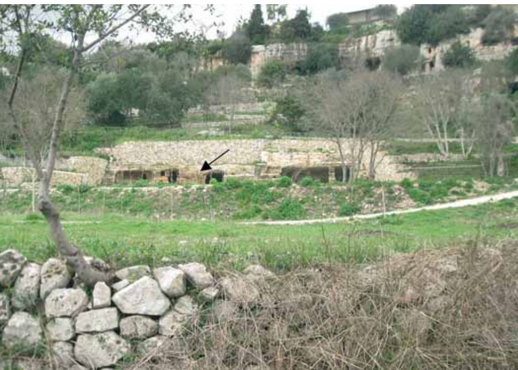
I lavori di consolidamento con le murature a secco rinverdite sottostanti la strada e poggianti direttamente nelle coperture delle grotte e, con la freccia, quelli di stabilizzazione con grate vive e grate d'Ispica nel Parco Archeologico di Cava d'Ispica a Modica (Ragusa) a 6 mesi dalla conclusione delle opere. (Foto Pirrera, feb. 2012)
